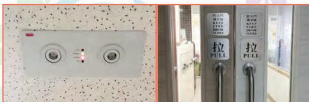
中心設備符合消防要求，於走火路線設置緊急照明系統 防火門長期合上
